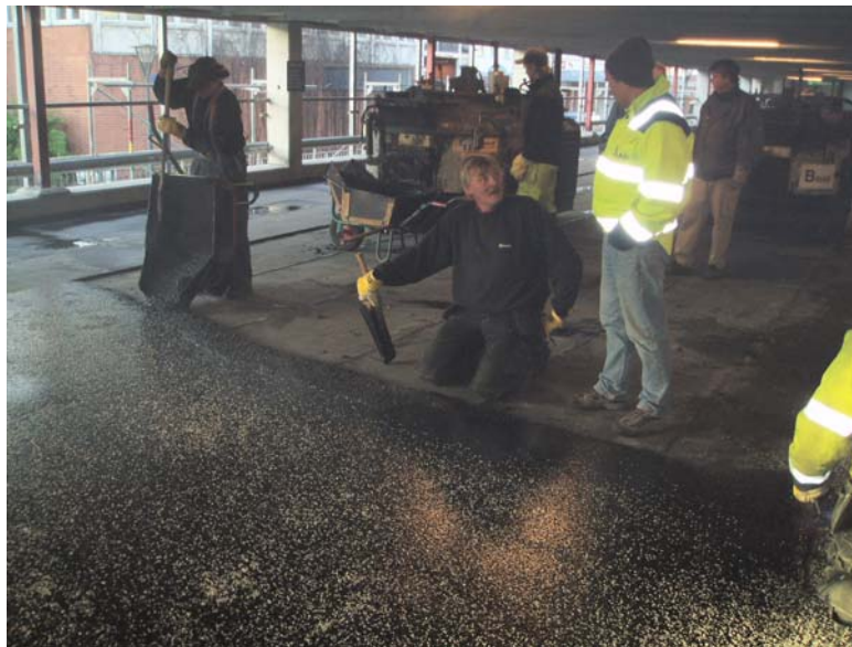
Rökutveckling vid läggning av PGJA med vaxinblandning
