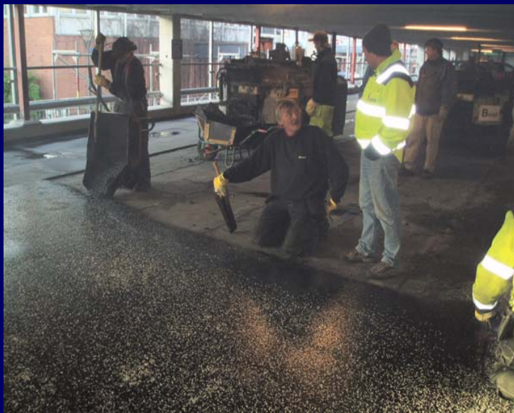
Läggning av gjutasfalt med inblandning av vax vid temperatur +200 grader
