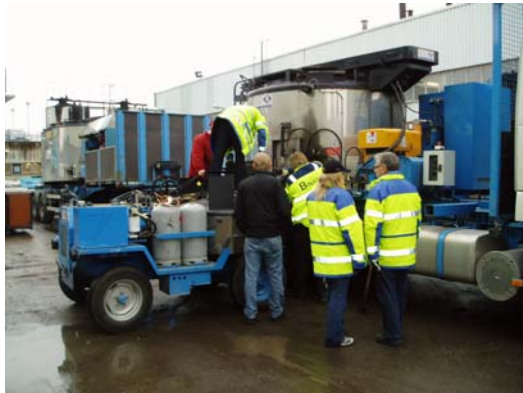
Tappning av första satsen av gjutasfalt vid fullskaleprovningen.
