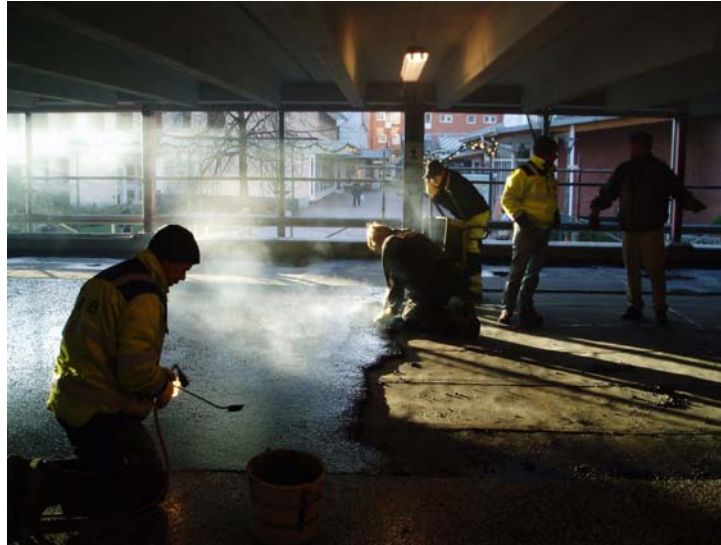
Rökutveckling vid läggning av PGJA utan vaxinblandning
