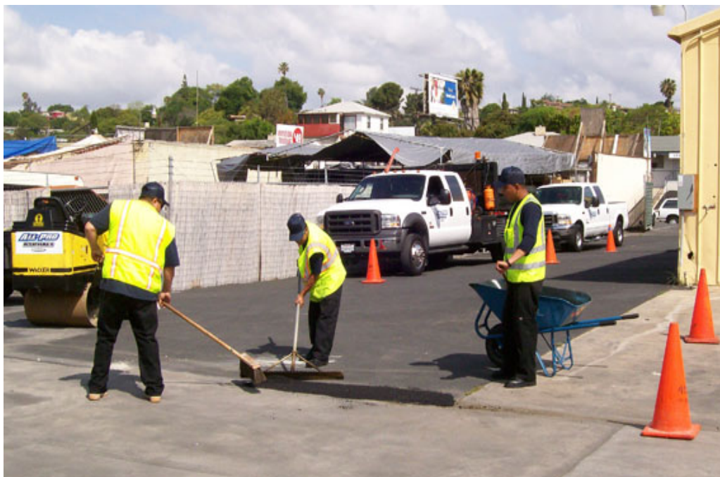
Bild nr. 2.6.1. Läggnig av AB- massa med hand redskap.
